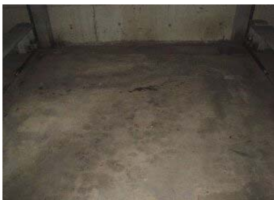
ピット内状況
