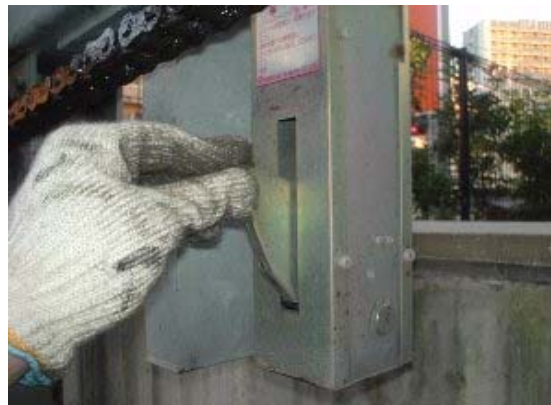
パレット受け装置動作確認
