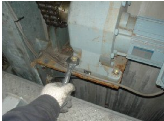
昇降モーター取り付けボルト増し締め
