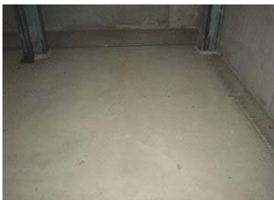
ピット内状況
