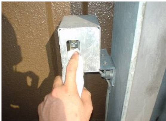
光電管センサーレンズ面清掃
